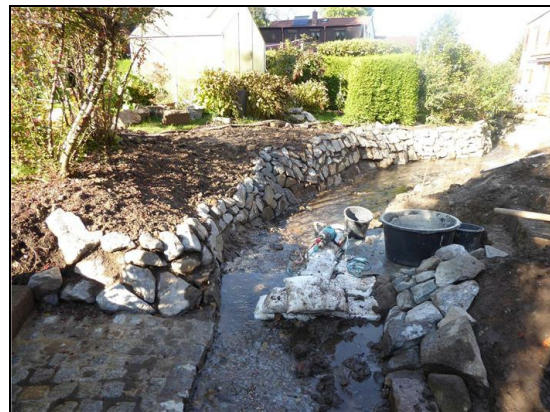
Abb. 5: während der Maßnahme: Aufgeweitetes Profil, mit offenem Steinsatz befestigte Uferböschung - Blick stromab, 07.10.2019
