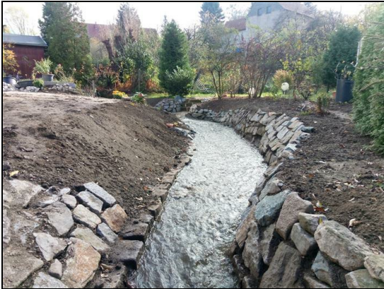
Abb. 8: Nach Fertigstellung - naturnah gestalteter Gewässerlauf mit Sohlsicherung und randlicher Gestaltung durch Anlieger; Blick stromauf, 30.10.2019
