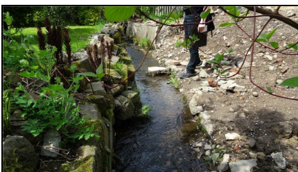
Abb. 1: Vor der Maßnahme: baulich eingegengtes Abflussprofil, rechts durch private Baumaßnahme bereits abgebrochen Ufermauer, Blick stromab, 24.04.2018
