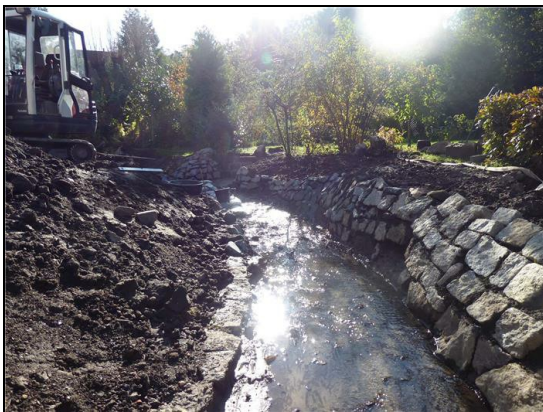
Abb. 4: während der Maßnahme: Aufgeweitetes Profil, mit offenem Steinsatz befestigte Uferböschung - Blick stromauf, 07.10.2019
